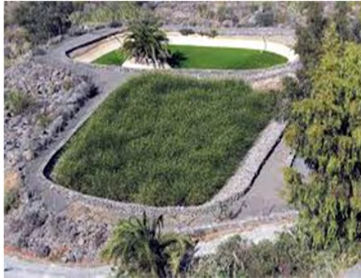
Figura 15: Sistema de tratamiento secundario Humedales.
