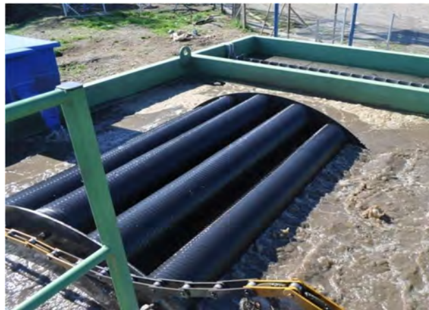
Figura 10: Sistema de tratamiento secundario STAM.
